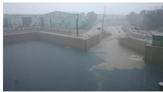
圖 10 抽水站及滯洪池發揮功能現況照片(資料來源：新北市政府)
